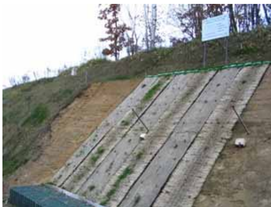
写真-2 施工直後(2005.11.1)
