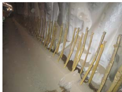
インバート鉄筋区間
