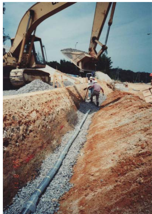
施工写真②
