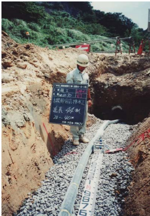
施工写真①
